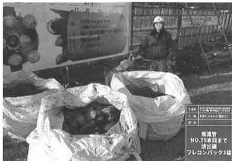
写真-9 破碎排土された巨石群
